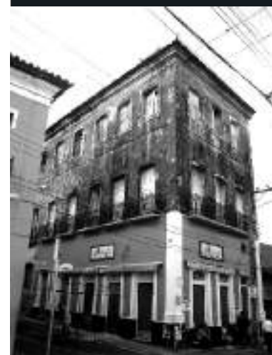
Intervenção para recuperação do Imóvel, São Luis/MA
