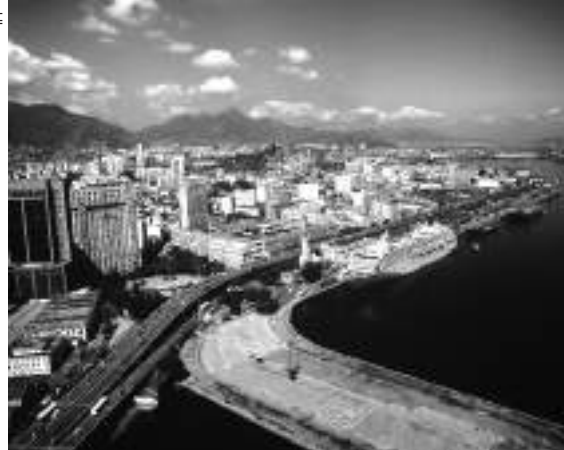
Vista do Pier Mauá, Porto do Rio de Janeiro
