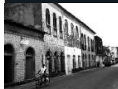
Degradação do casario, São Luis /MA
